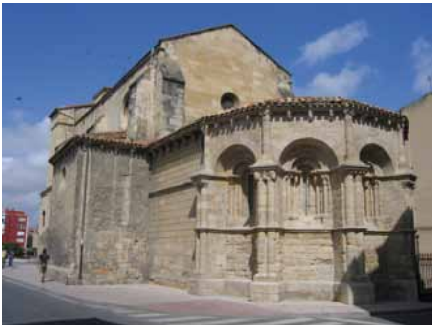
Ábside de la Iglesia del Espíritu Santo de Miranda de Ebro
